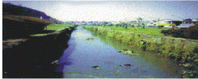
Foto Situação Atual
